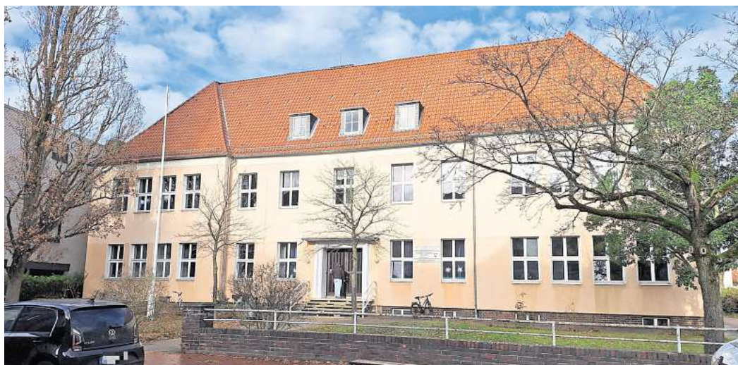
Die Stadt hat die Heizungsanlage der Ingo-Siegner-Grundschule instand gesetzt. Foto: Jakob Buddenbohm
