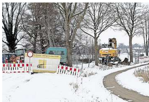
Die Arbeiten ruhen: Das winterliche Wetter verhält der Region Hannover den Zeitplan für die Brückensanierung auf der Kreisstraße 127. Foto: Sven Warnecke
