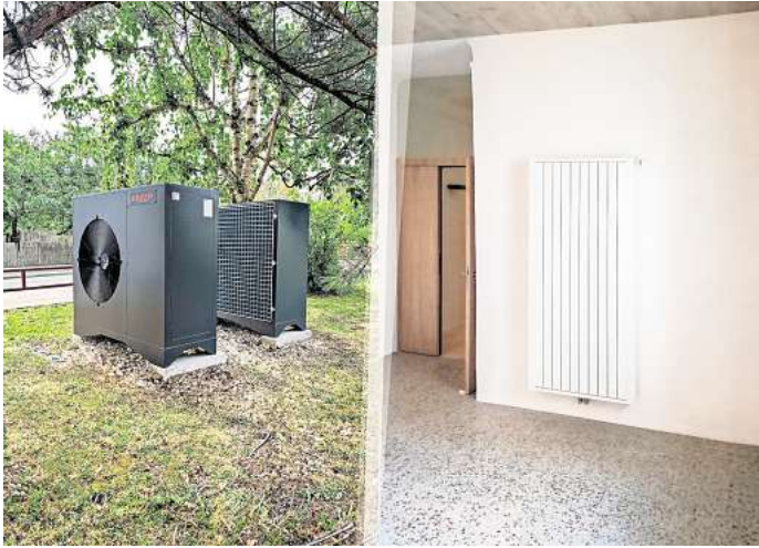
Der Aluminium-Heizkörper ist speziell für den Betrieb mit geringen Vorlauftemperaturen von maximal 45 Grad Celsius konzipiert und arbeitet komplett ohne elektrischen Motor, wie es üblicherweise bei Wärmepumpen-Heizkörpern der Fall ist.
