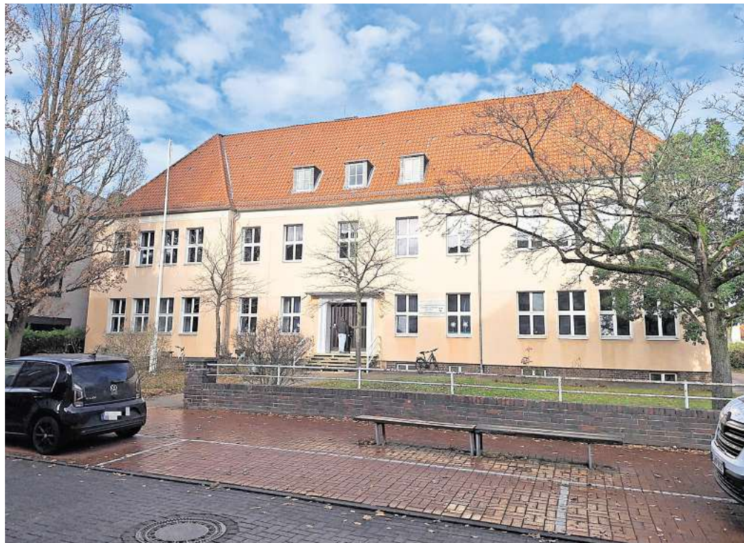
Hat bauliche Mängel und benötigt mehr Platz: die Ingo-Siegner-Grundschule in Burgdorf.
