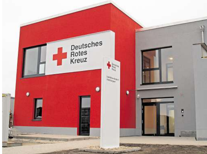
Der Haupteingang: Das ist die neue DRK-Rettungswache in Burgdorf. Fotos: Stephan Hartung
