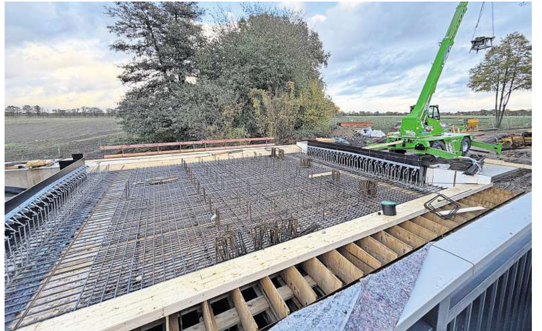
Teures Vergnügen: Gut 1,5 Millionen Euro investiert die Region Hannover in den Neubau einer Brücke über die Erse zwischen Uetze und Eltze. Foto: Sven Warnecke
