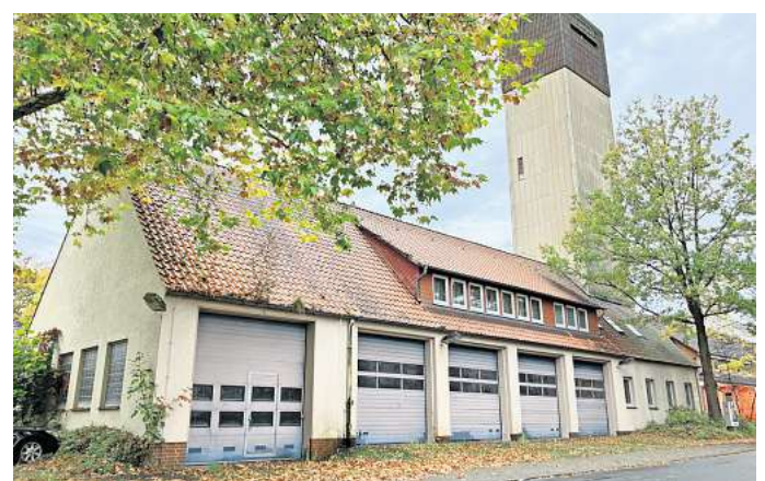
2027 soll gebaut werden: Auf dem Gelände der leerstehenden Feuerwehrtechnischen Zentrale am Marris-Mühlenweg sollen Sozialwohnungen entstehen. Foto: Emily Bader
