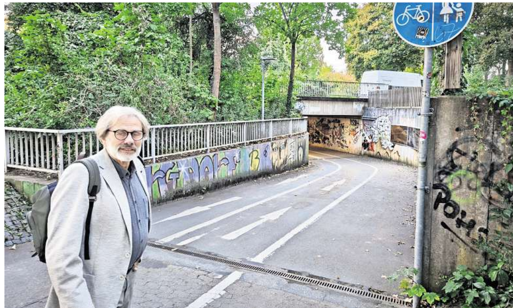
Mehr Sicherheit für Radfahrer: Grünen-Ratsherr Hartmut Braun am Finanzamtunnel, der nun modernisiert werden soll.
