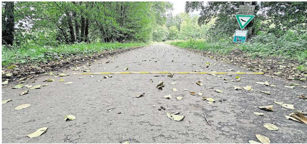
Der Zollstock verrät es: Die Umleitungsstrecke ist mit etwa drei Metern sehr schmal, die Seitenränder nicht befestigt. Sven Warnecke
