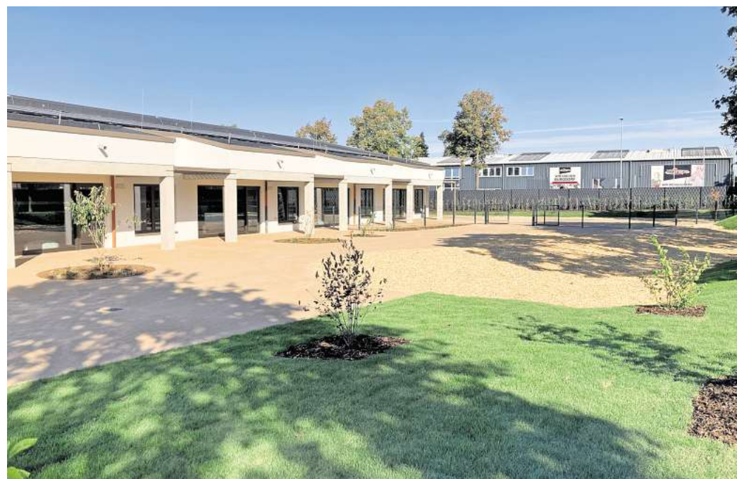
Außengelände: Aus allen Räumen der Kinderbetreuung gelangt man nach draußen, wo demnächst noch die Spielgeräte installiert werden. Foto: Stephan Hartung
