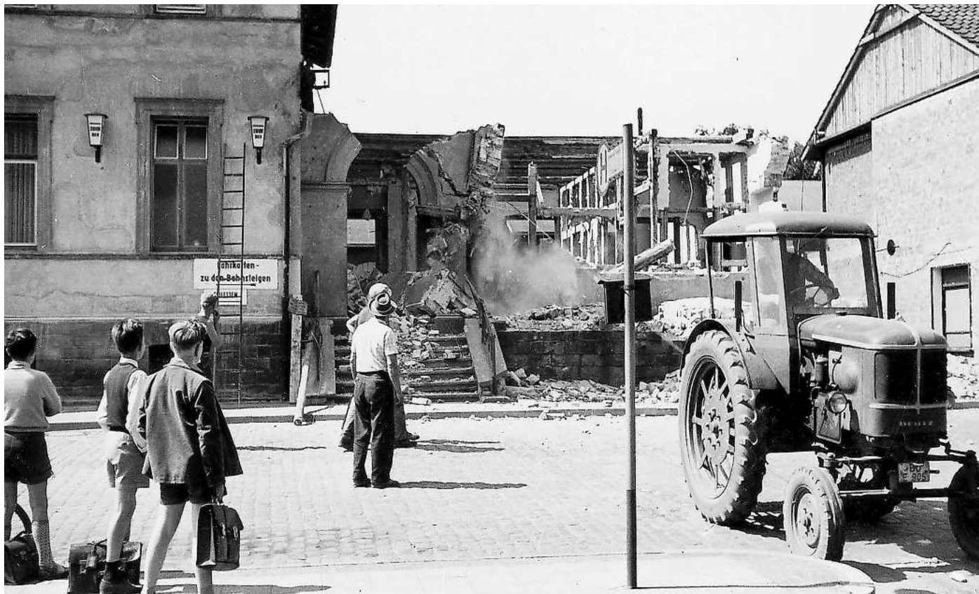
Der Burgdorfer Bahnhof wird 1959 umgebaut.
