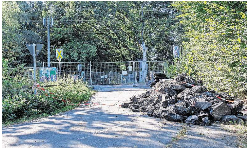
Ausgebaut: Am Bahnübergang in Ahrbeck wurde der Asphalt zwischen den Gleisen durch Schotter ersetzt. Foto: Joachim Lührs
