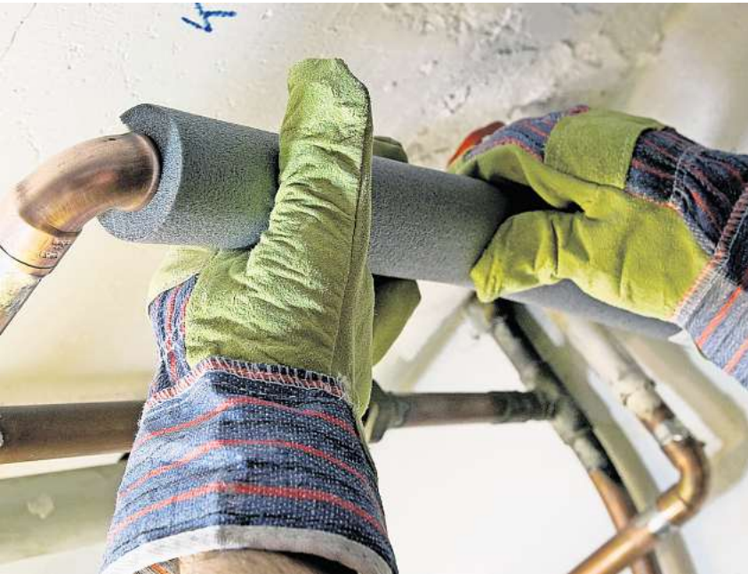
Die Rohrisolierung kann den Energieverbrauch der Heizung deutlich reduzieren.
