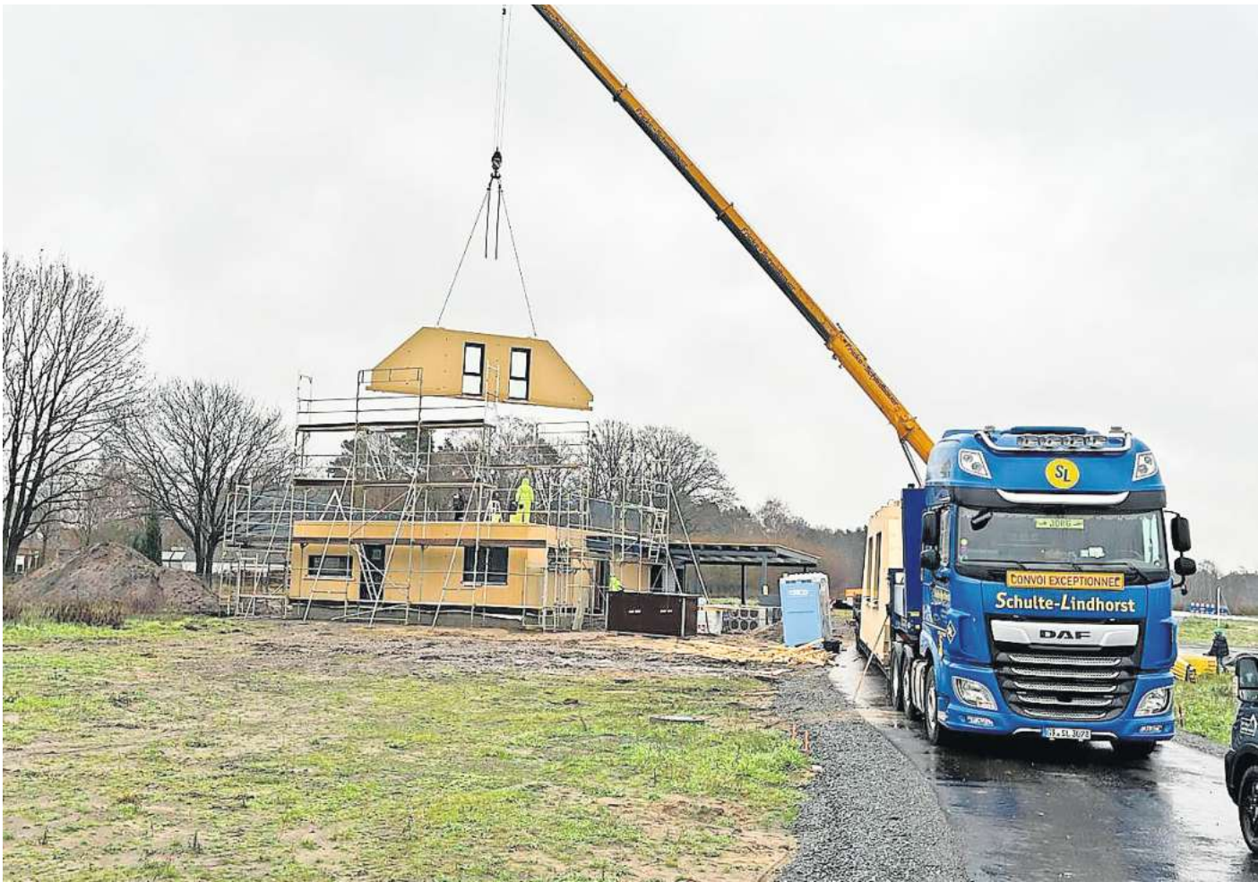
Anlieferung: Mit einem Kran werden die Hausteile auf das Grundstück im Baugebiet „Schillerslager Straße Ost“ gehoben. Foto: Privat
