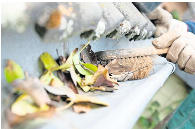
Um Wasserschäden vorzubeugen, sollten Regenrinnen regelmäßig von Laub befreit werden.
