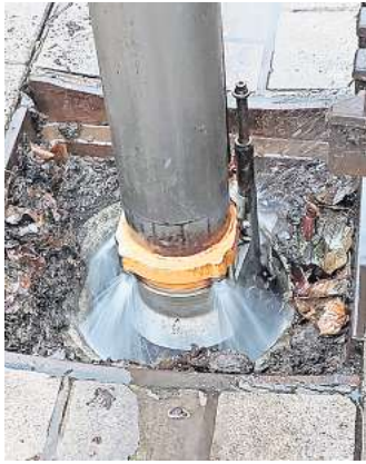
Maschine statt Mensch: In Burgwedel kommt ein Sinkkastenreiniger zum Einsatz, um Regenabläufe von Laub zu befreien. Foto: Stadt Burgwedel
