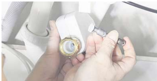
Schläuche von Waschmaschinen sollten mit einem Aquastop gesichert werden. Bildquelle: Schraub-Doc
