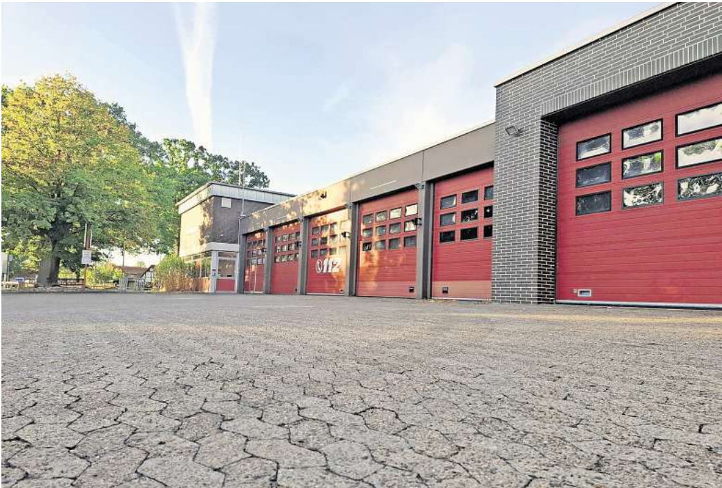
Der bisherige Standort: das Feuerwehrhaus Großburgwedel am Mühlenbruchdamm. Foto: Frank Walter
