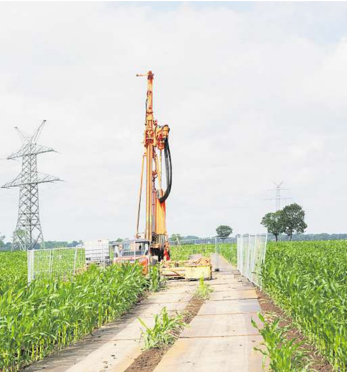
Baugrunduntersuchungen für die neue 380-kV-Leitung: TenneT setzt die Arbeiten nun in Isernhagen und Burgwedel fort.
