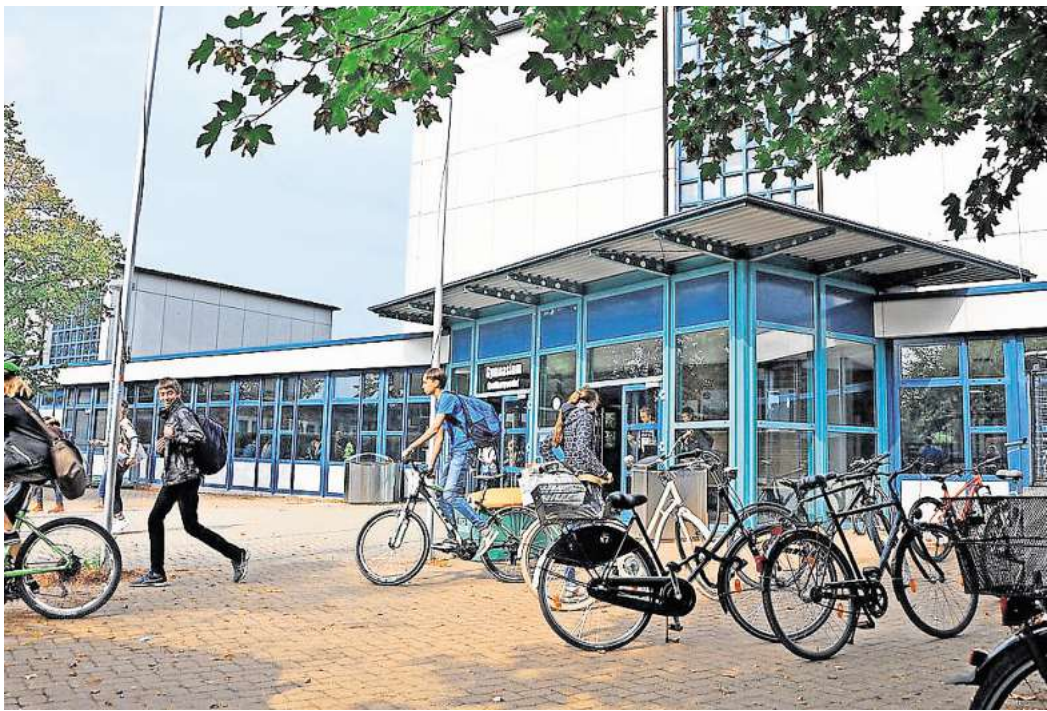
Wird für 48 Millionen Euro neu gebaut: Das Gymnasium Großburgwedel.
