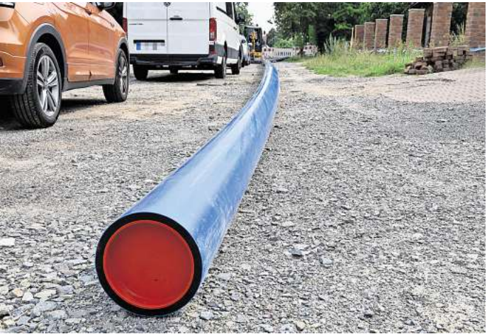
Lange Rohre: Im dritten Bauabschnitt der K113 werden gerade Wasserleitungen erneuert. Foto: Frank Walter
