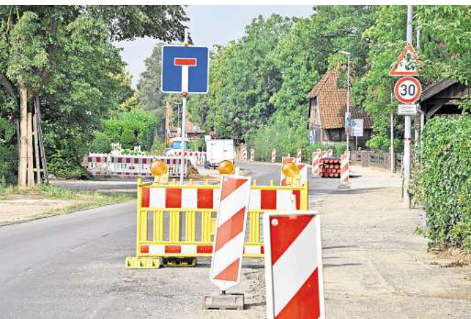
Dauerbaustelle K113: Die Arbeiten am dritten und letzten Bauabschnitt werden voraussichtlich erst im Frühjahr 2027 abgeschlossen. Foto: Frank Walter
