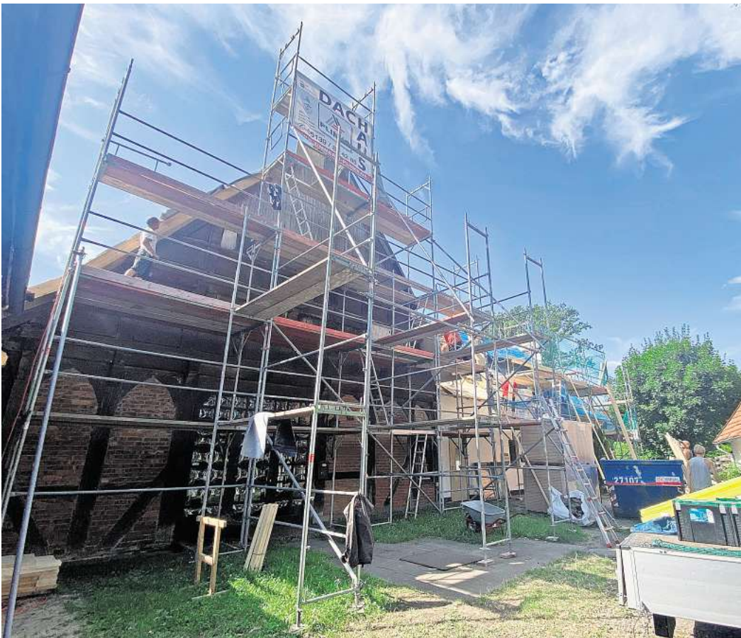
1592 errichtet: Eines der ältesten Häuser Isernhagens bekommt ein neues Dach.
