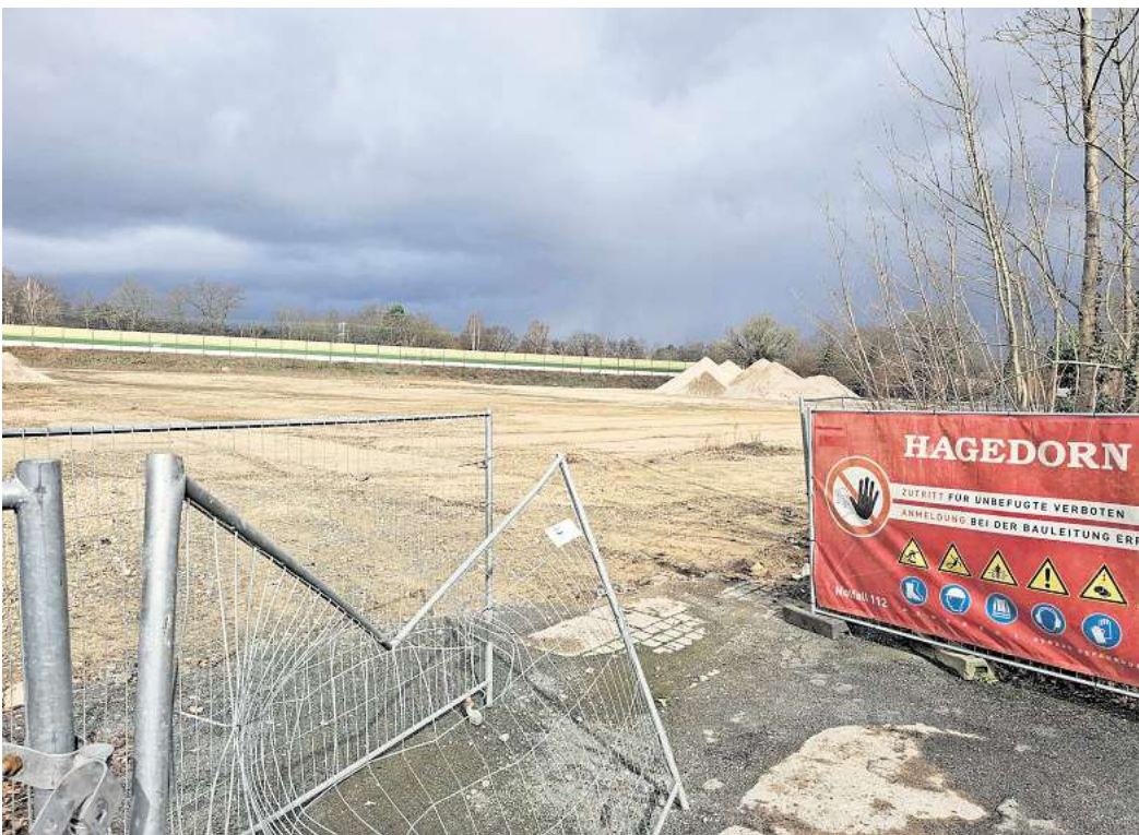
Das Bode-Gelände in Isernhagen: Der Rat hat nun beschlossen, dass hier 150 Wohneinheiten entstehen sollen.
