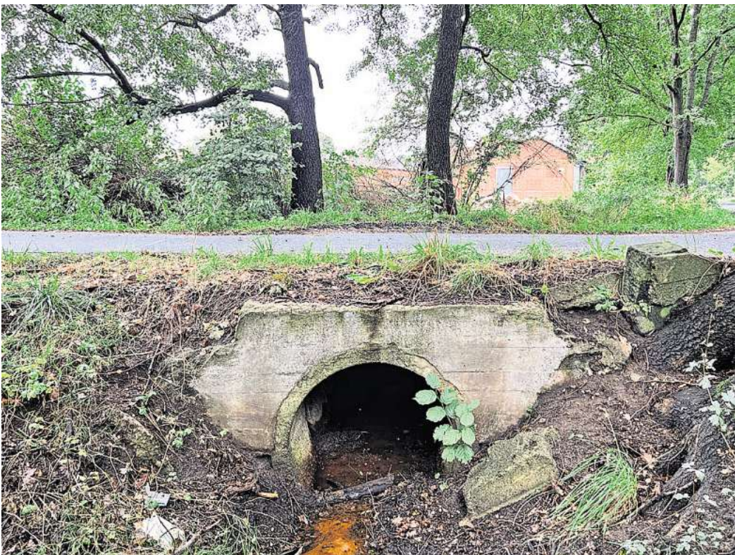
An der Kreuzung Wettmarer Weg/Grasbruchweg beginnt Anfang August der erste Bauabschnitt für die neue Abwasserdruckrohrleitung. Foto: Ingenieurbüro Spiekermann
