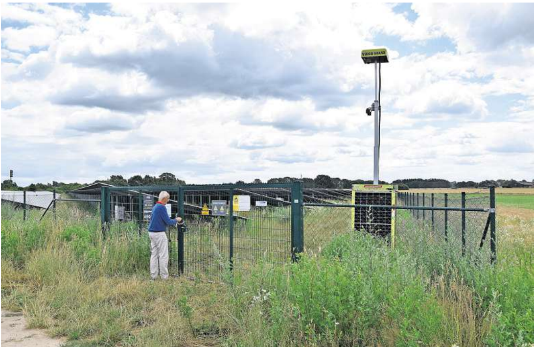
Mittlerweile videoüberwacht: einer von mehrere Masten mit Kameras im Solarpark. Foto: Frank Walter
