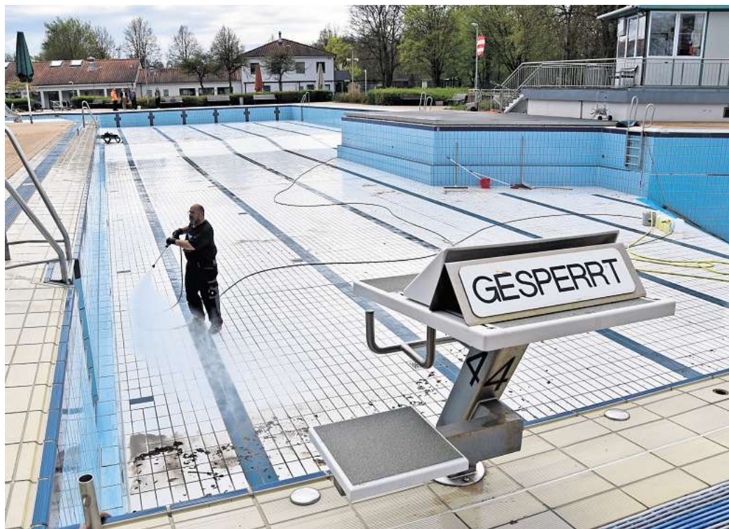
Vor dem Wassereinlass steht die Reinigung an: Alexander Serebrennikov säubert den Beckengrund mit einem Hochdruckreiniger. Foto: Frank Walter
