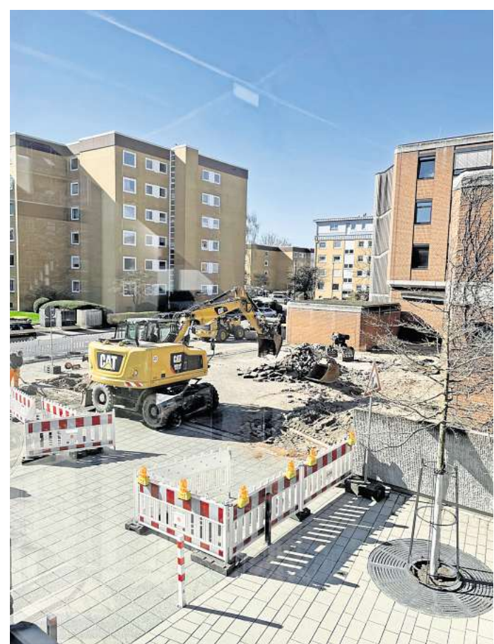
Die Arbeiten für den fünften Bauabschnitt der Städtebaufördermaßnahme „Zentrum Isernhagen“ in der Stettiner Straße haben begonnen. Foto: Svenja Theunert/Gemeinde Isernhagen
