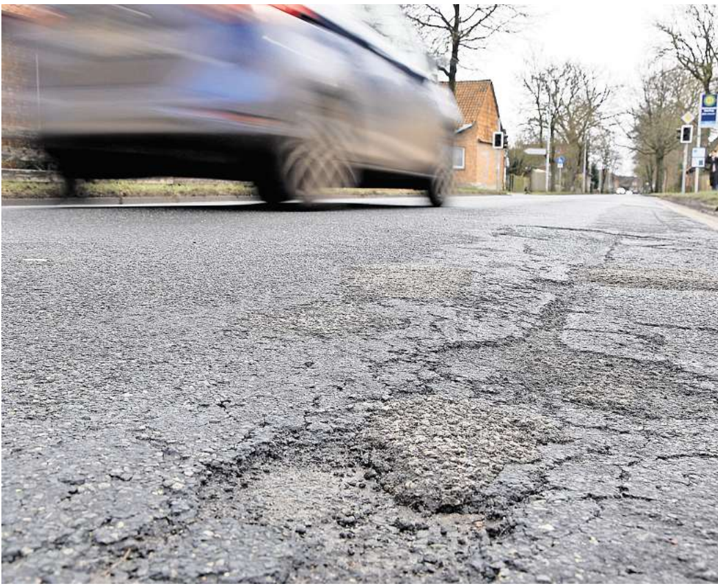
Flickstellen und Schlaglöcher: Die Fahrbahndecke ist in keinem guten Zustand.
