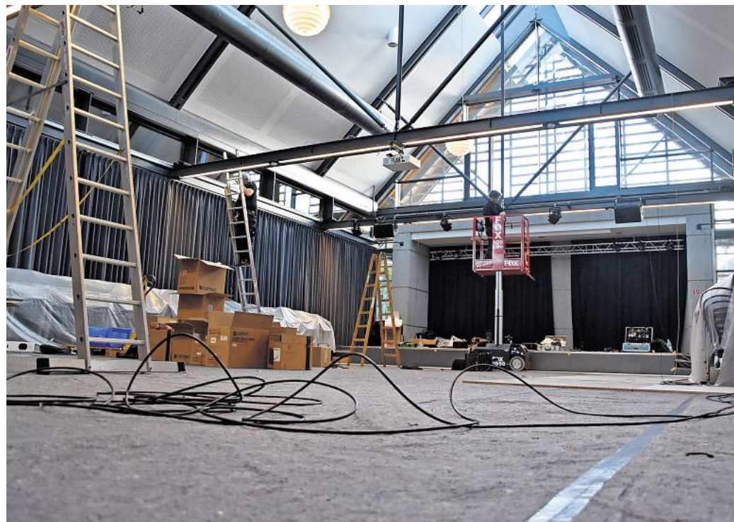
Wird technisch modernisiert: der Veranstaltungssaal Amtshof in Großburgwedel. Fotos: Frank Walter
