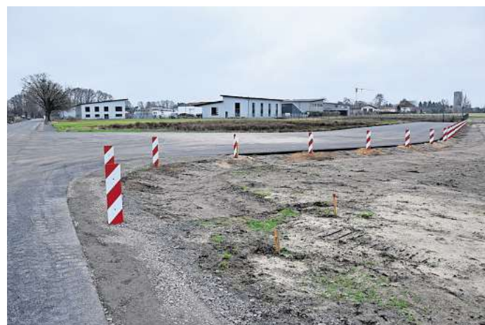
Viel Platz für neue Unternehmen: Baken säumen die Baustraße.
