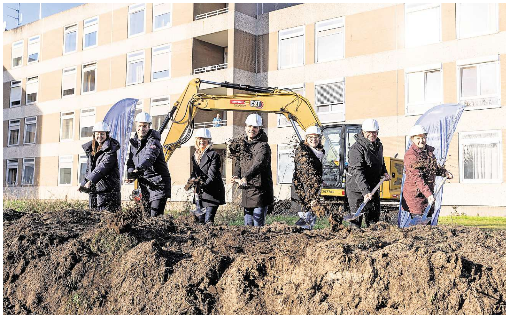
Spatenstich für den neuen Geriatrie-Standort am KRH Klinikum Großburgwedel (v. l.): Lea Matschke vom Generalunternehmer ALHO Systembau, PD Dr. Klaus Tim Kaufeld, Geschäftsführender Kaufmännischer und Ärztlicher Direktor des KRH Klinikum Großburgwedel, Barbara Schulte, KRH Geschäftsführerin Finanzen und Infrastruktur, Steffen Krach, Regionspräsident und KRH Aufsichtsratsvorsitzender, Ortrud Wendt, Bürgermeisterin der Stadt Burgwedel, Dr. Matthias Bracht, KRH Geschäftsführer Medizin, und Nora Nitschke, Projektleiterin KRH Klinikum Region Hannover.
