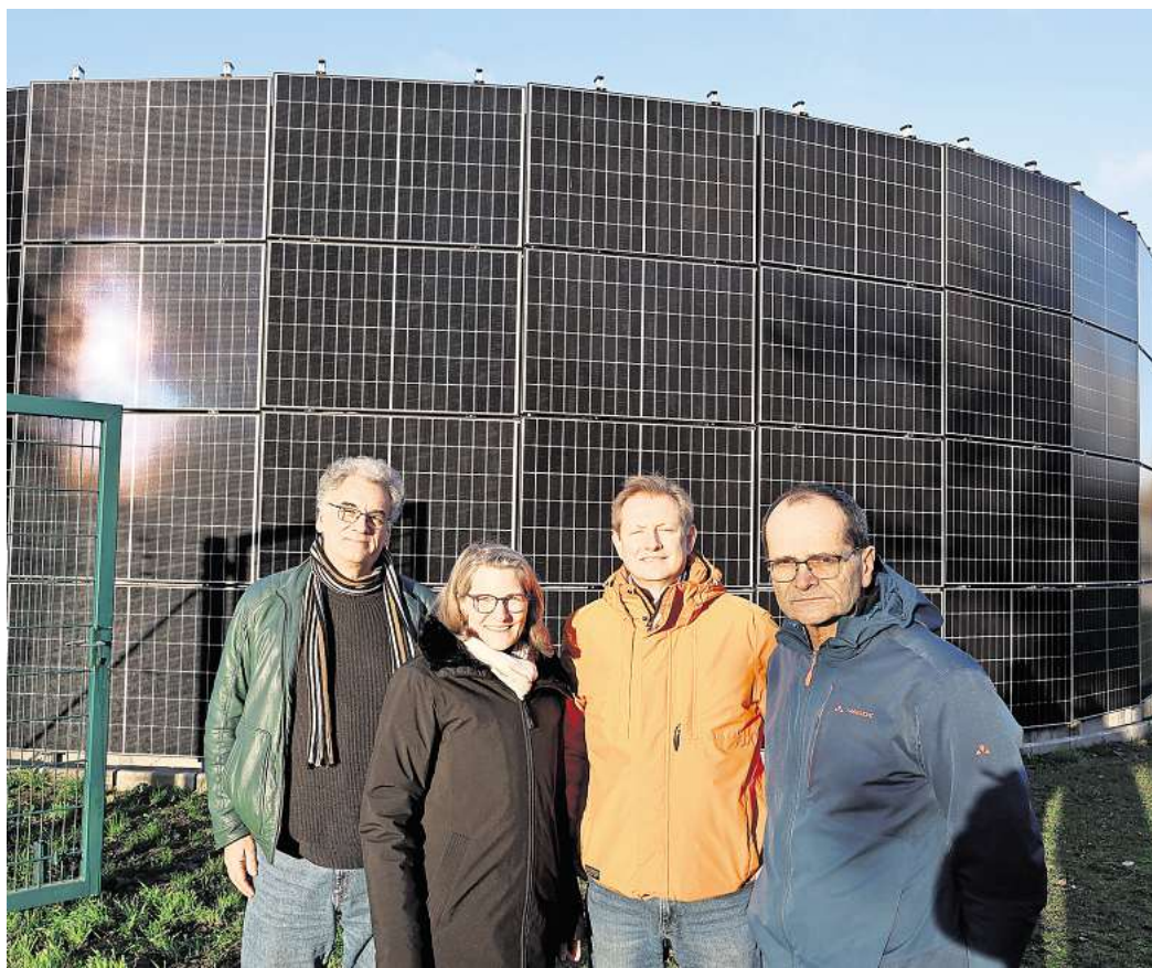
Montiert an einem Klärschlammilo: Genossenschaftsvorsitzender Dirk Behrens (von links), Bürgermeisterin Ortrud Wendt, Genossenschaftsvorstand Guido Vaupel und Umweltkoordinator Malte Schubert besichtigen die neue Solaranlage im Burgwedeler Klärwerk.
