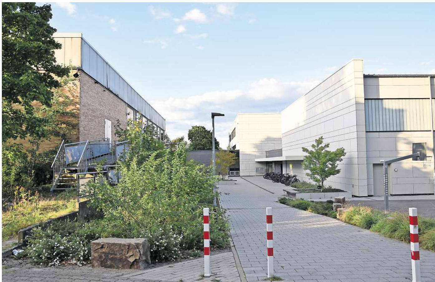
Alt und neu stehen nebeneinander: links die alte Aula des Gymnasiums, rechts die neue Sporthalle und der SEK-I-Trakt. Foto: Frank Walter
