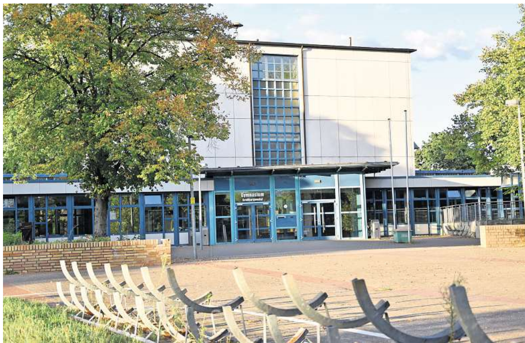
Wird größtenteils neu gebaut: das Gymnasium Großburgwedel. Foto: Frank Walter
