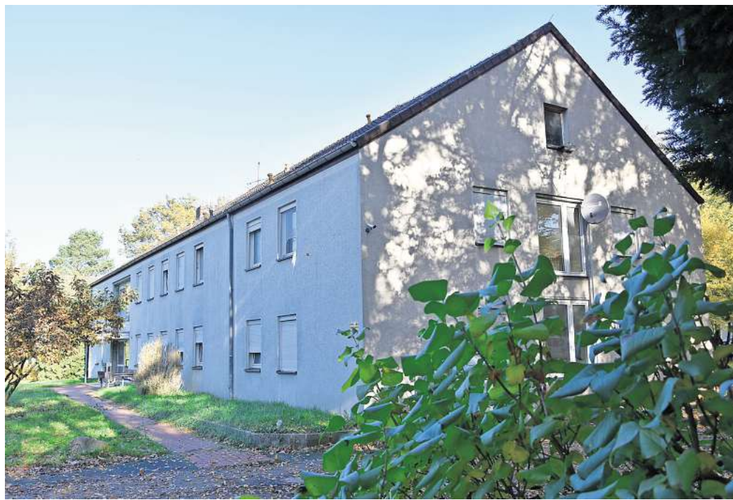
Eine der größeren Unterkünfte für Flüchtlinge: das ehemalige Schwesternwohnheim in Großburgwedel. Foto: Frank Walter
