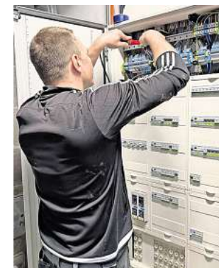
Tim Theune bei der Anschlussüberprüfung einer neuen Zähleranlage.
