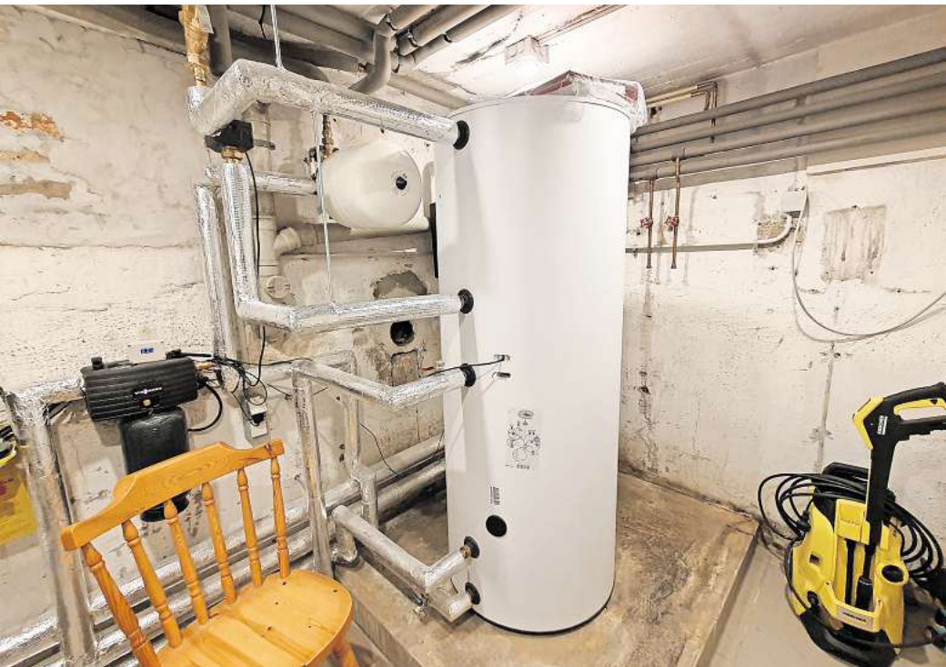
Heiztechnik im Keller: Wo früher der alte Heizkessel der Ölheizung stand, ist jetzt der neue für die Wärmepumpe angeschlossen. Foto: Sandra Köhler
