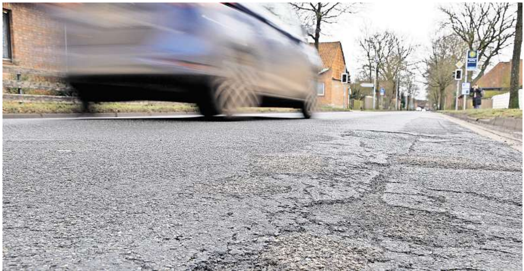
Flickstellen und Schlaglöcher: Die Fahrbahndecke ist in keinem guten Zustand.
