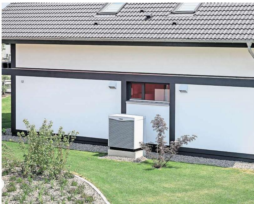
Die Luft-Luft-Wärmepumpe entzieht der Außenluft Wärme, um damit die Raumluft zu erwärmen. Foto: Daniel Maurer
